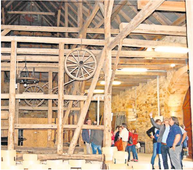
Die Schäferscheune in Sillium soll einen gepflasterten Fußboden wie die Zehntscheune in Freden bekommen.
